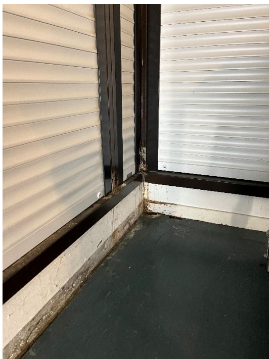
ETAT DES SOLS ET PLINTHES A REMPLACER
