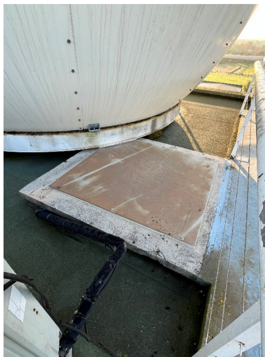
EDICULE ASCENSEUR – ANCIENNE SORTIE MONTE CHARGE A ETANCHER
