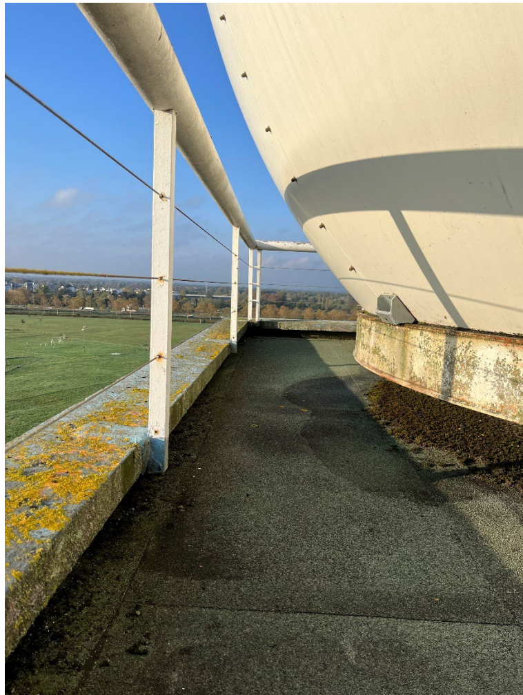
GARDE CORPS A REMPLACER – TERRASSE R+7
