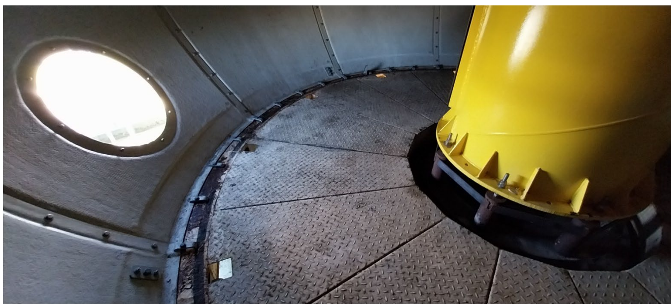
VUE DE L'ÉTANCHEITE SOUS ET DANS LE RADOME – TRAITEMENT ANTICORROSION DE LA COURONNE METALLIQUE ET DU PLATELAGE EN TOLE LARMEE
