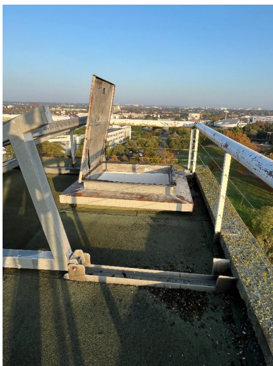
Trappe d'accès terrasse R+7 laissée en place - Chevalet métallique à déposer
