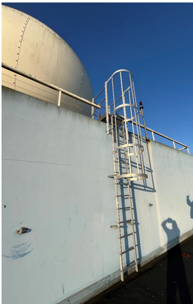
Echelle à crinoline à remplacer – Terrasse R+6
